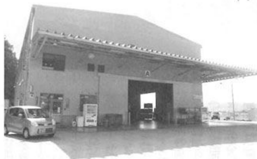
営業所 天井部分に太陽光パネルが敷設される
