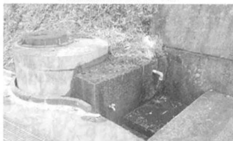
中田商事の敷地内から出る湧き水
