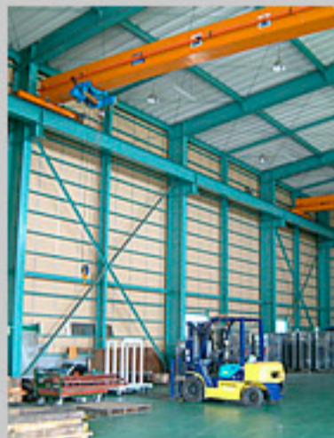
2基のクレーンが設置されている倉庫。ここで、別々の荷主の荷物を1台のトラックに積載するなど、配車効率を高める工夫もしている
