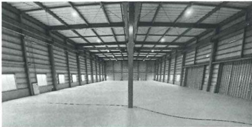
営業倉庫登録をした友生倉庫
